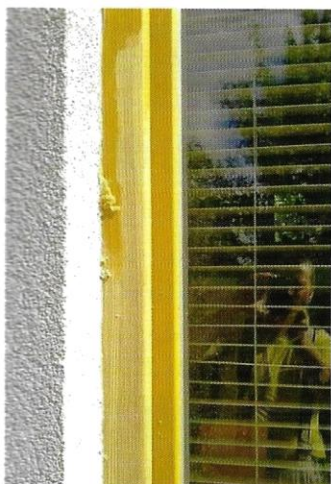
Obr. 2: Odstranění původních nátěrů eurookna.
