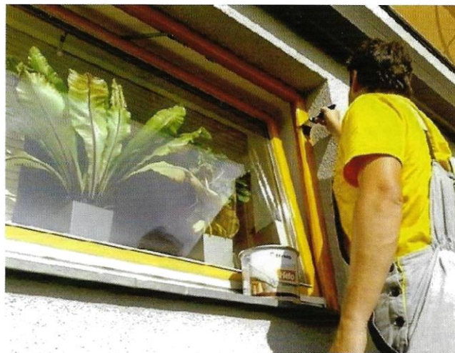
Obr. 4: Finální úprava eurooken uretanovo-alkydovým lakem.
