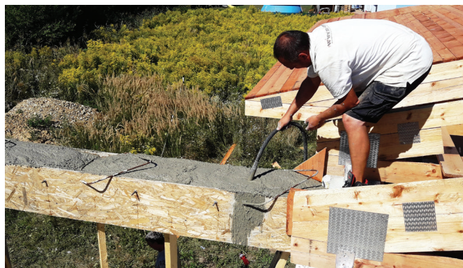
Obr. 7: Ztužující pás (věnec) – jeho uložení, provázání a betonáž včetně zhutnění – je důležitým stavebním prvkem, který je nutno kontrolovat, neboť plní funkci nosnou a kotevní (zachycuje ve svislých stavebních konstrukcích tahové síly a rovnoměrně roznáší zatížení).
