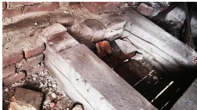
Obr. 4: Ukázka uložení nosných trámů vodorovné stropní konstrukce – pohled na zhlaví trámu po odkrytí podlahy.
