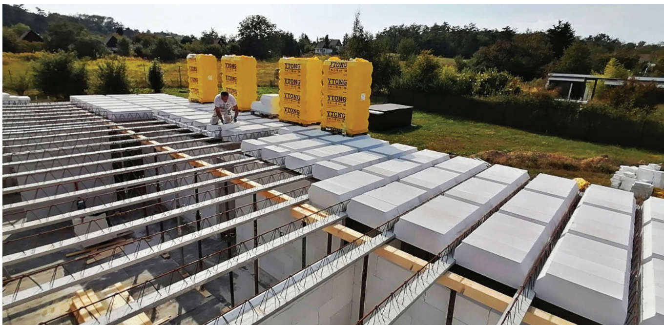
Obr. 1: Ukázka vodorovné stropní konstrukce (stropní vložky Ytong).
