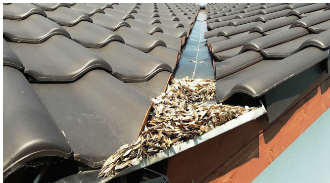
Obr. 10: Pravidelná údržba šikmé střechy alespoň 1x do roka zaručuje, že se na ní nebude kumulovat dešťová voda, která by poškozovala ostatní stavební konstrukce.
