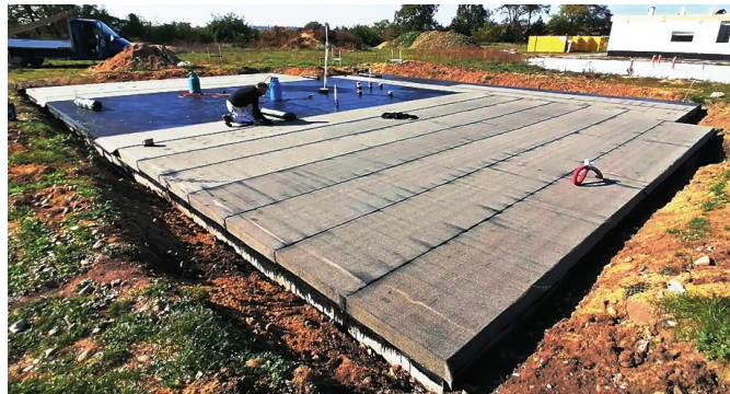
Obr. 4: Vodorovná hydroizolace stavebního objektu (asfaltové pásy).
