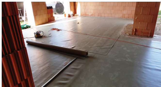
Obr. 7: Vodorovná hydroizolace stavebního objektu (PVC fólie).
