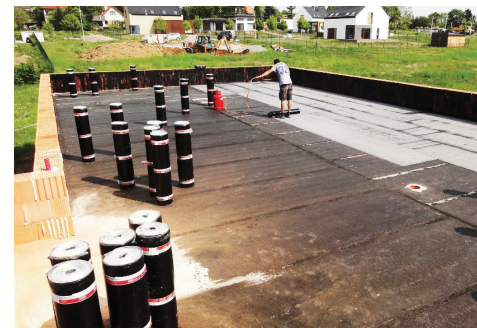
Obr. 4: Důraz na kontrolu detailů a provedení skladby celé stavební konstrukce od počátku výstavby.
