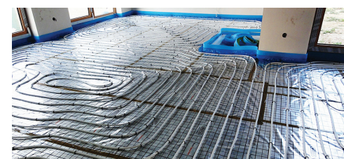
Ukázka realizace lití anhydritového potěru – při aplikaci musí být rozvod podlahového vytápění dobře ukothen a naplněn vodou – postupně zahřívání již po 7 dnech aplikace anhydritového potěru.
