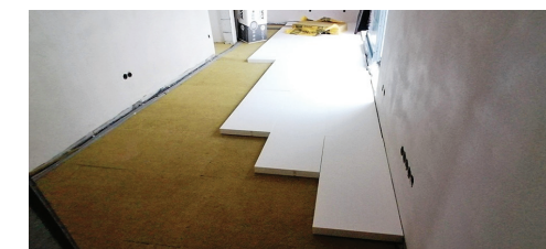
Příprava podkladu ve stavebním objektu, 1. NP – kročejová izolace – tepelná izolace.
