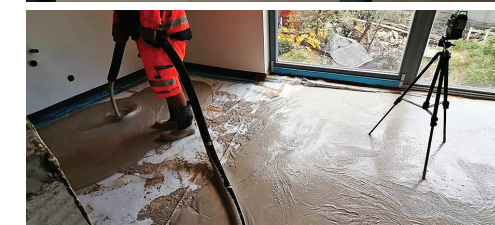
Lití anhydritového potěru (bez podlahového vytápění).
